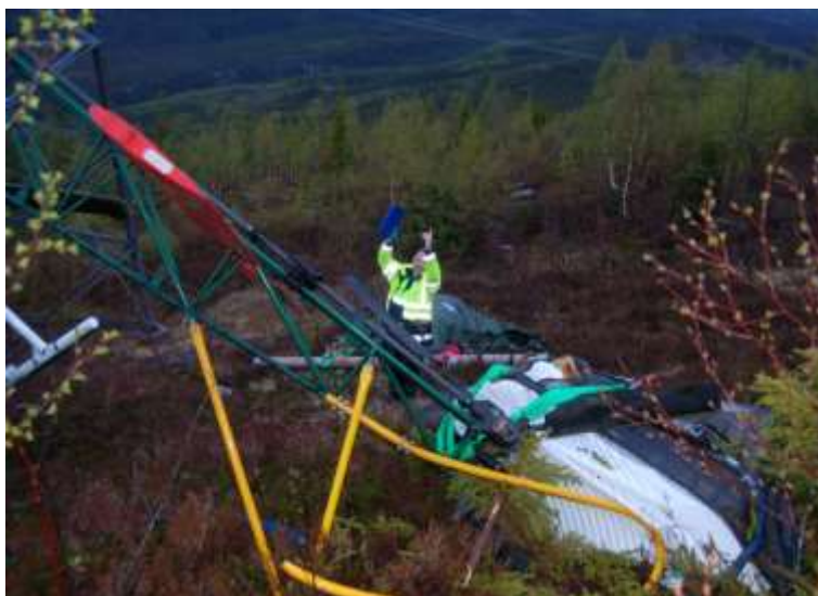
Figur 2: Havariinspektøren står og markerer punktet loddrett ned fra traversspissen. Merk at hiv nr. 1, under grønn presenning bak havariinspektøren, hadde rullet nedover og blitt liggende innenfor punktet loddrett ned fra traversspissen. Foto: SHT
