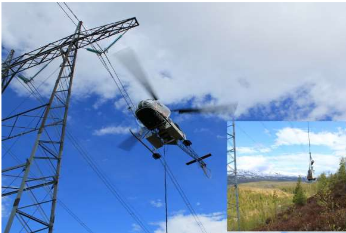
Figur 1: Helikopteret leverer første hiv ved mast 145. Fotografen står mellom masten og der hivet var ønsket levert. Innfelt bilde viser terrengets beskaffenhet. Lasten ble satt ned nærmere masten enn bildet viser. Foto: Infratek
