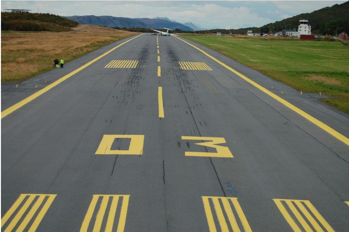
Figur 9: Terrengtet på utsiden av rullebanen. Foto: SHT
