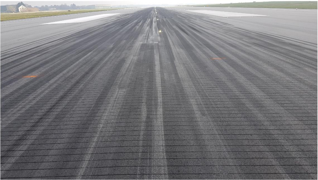
Figur 2: Første merker etter propellene markert med rødt. Foto: Plass-, brann- og redningstjenesten Sola
