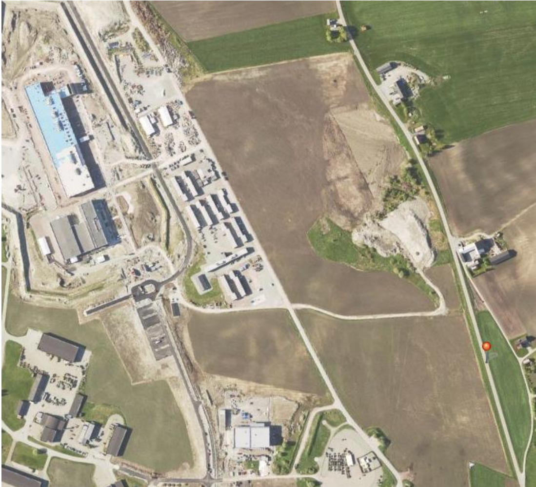
Figur 5: Nålmarkering i bildet viser stedet der bilen kjørte ut. Foto: Norge i bilder
