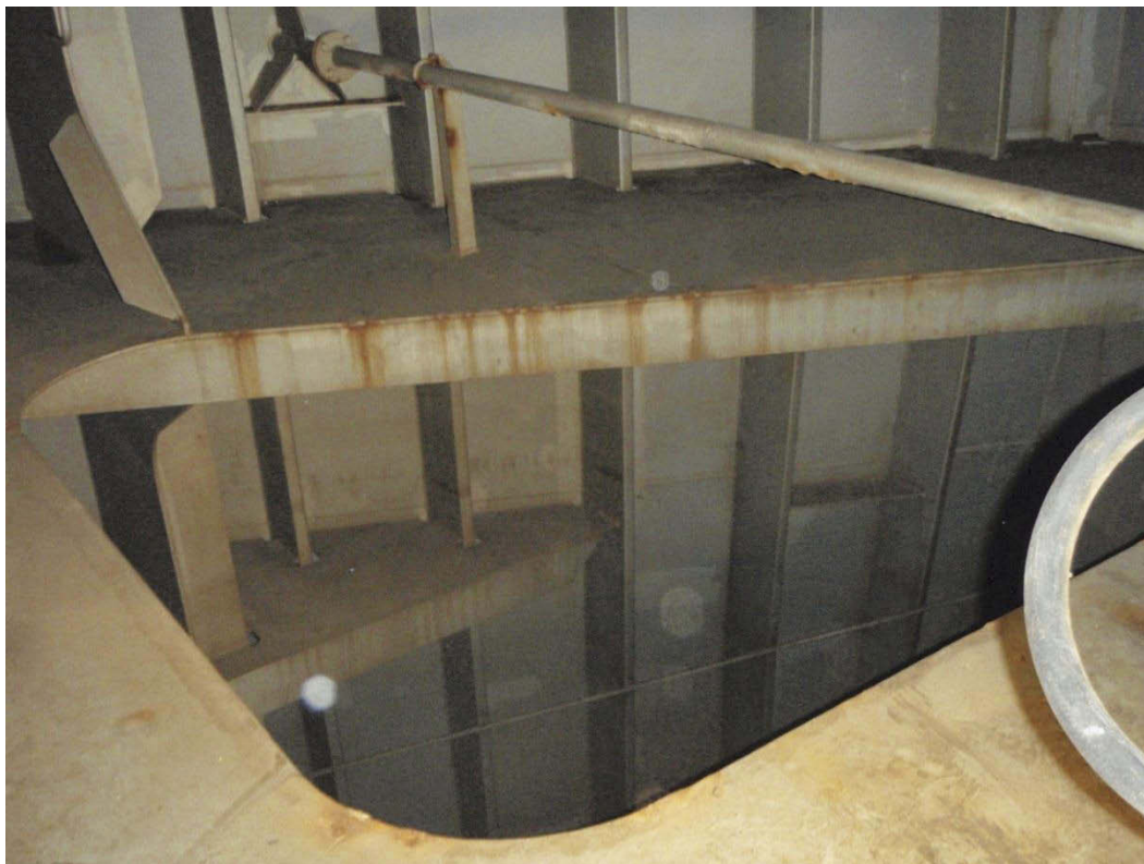
Figur 3: Åpningen i stringer 10200. Ejektorrøret øverst med flens og skroggjennomføring til venstre. Bildet er tatt fra senter mot babord.
