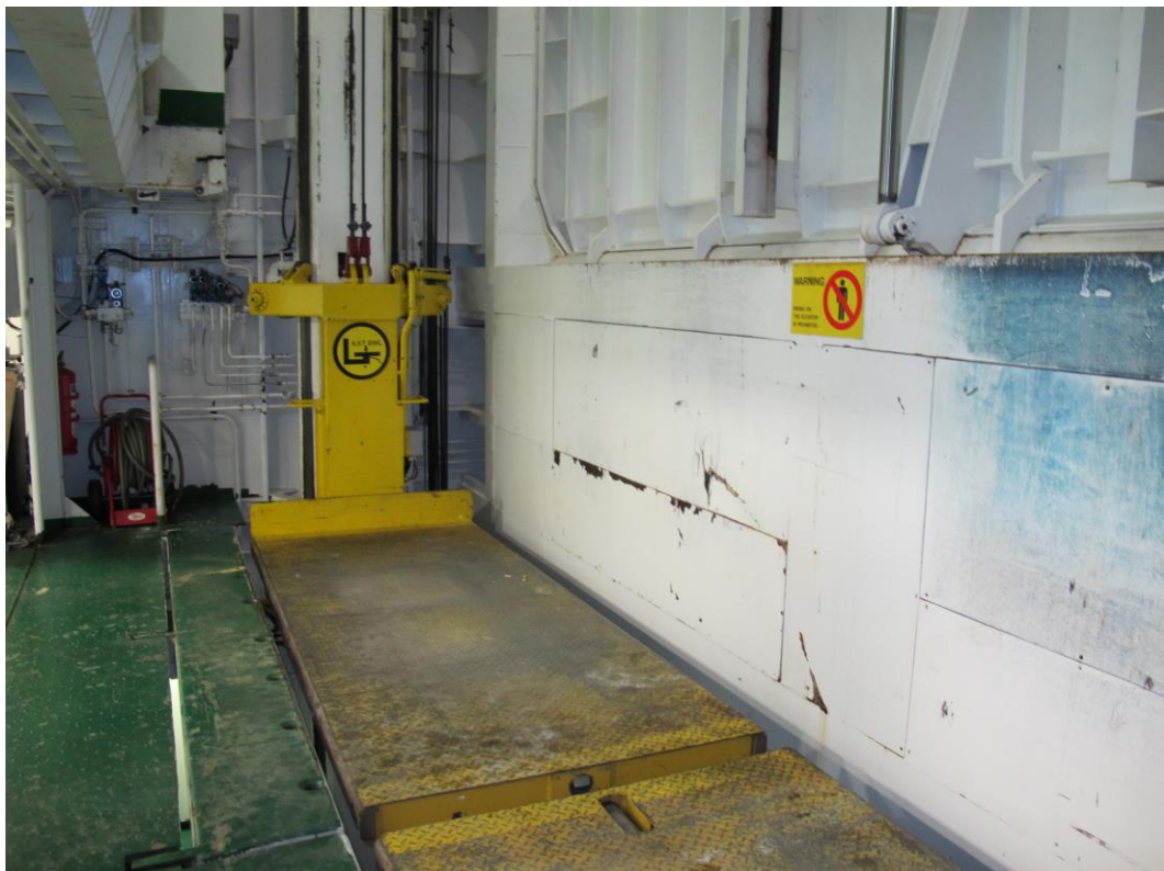
Figur 11: Palleheis på dekk 3, med synlig sideport. Foto: SHT
