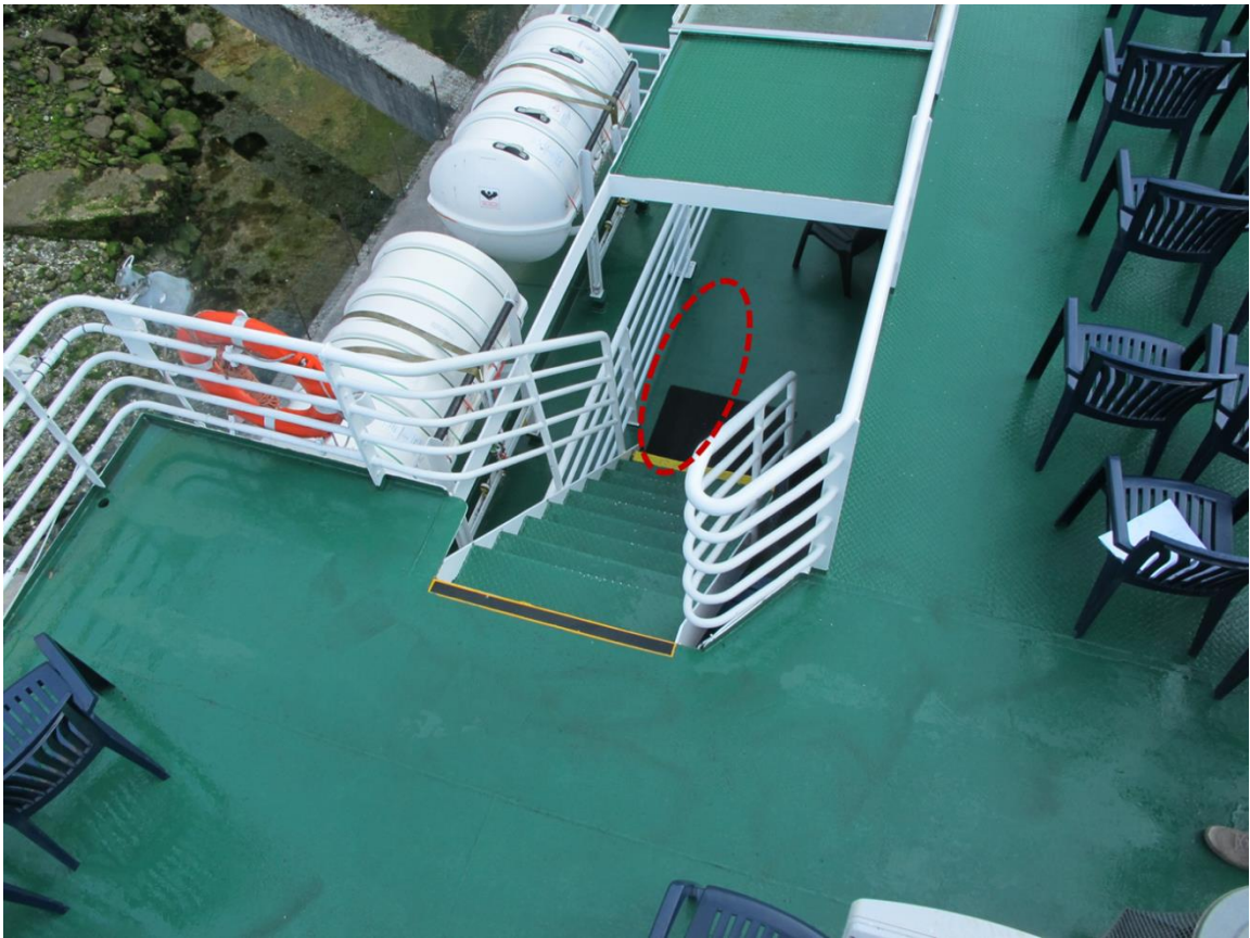
Figur 5: Brodekket med styrbord trappeløp sett ovenfra. Forulykkede ble funnet liggende på dekket nedenunder etter ulykken (markert område i rødt). Foto: SHT
