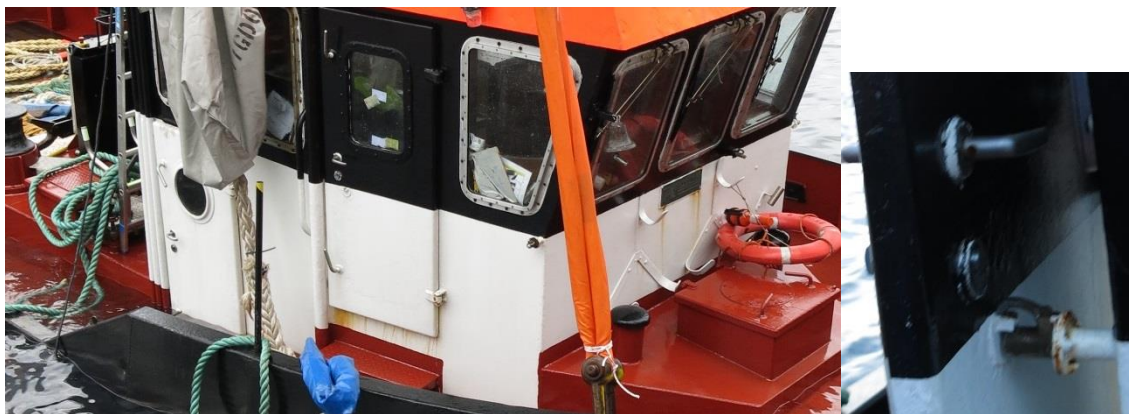
Figur 14: Dører og luker etter retting. Til høyre: Dørhake som holder styrehusdør i åpen stilling. Foto: SHT
