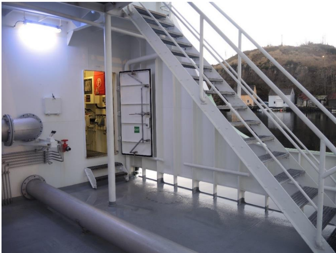
Figur 6: Babord inngang til maskinrommet fra hoveddekk. Foto: SHT
