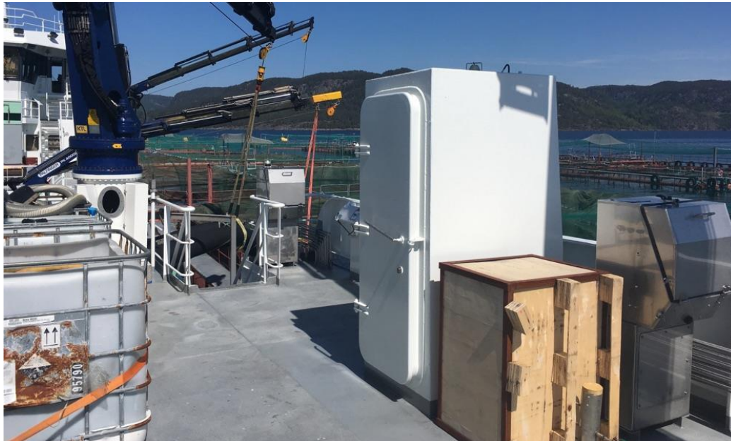
Figur 14: Nødutgangen fra maskinrommet etter endringen. Foto: Sølvtans
