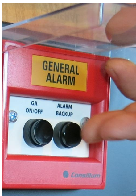
Figur 13: Generalalarm på bro. Foto: SHT
