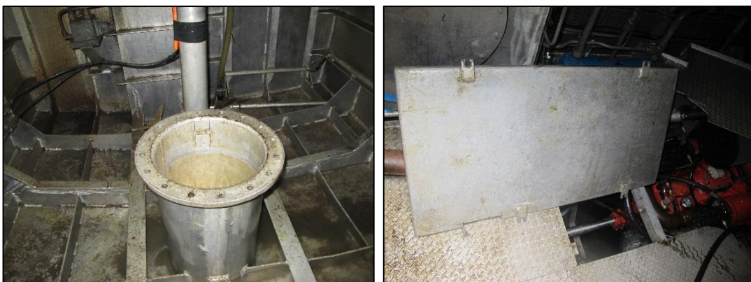
Figur 6: Til venstre sees inspeksjonsrøret hvor selve luken er fjernet. Til høyre sees døren i aktre styrbord maskinromskott som også ble demontert og forlatt i åpen stilling. Foto: SHT
