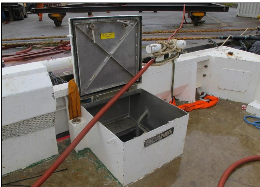
Figur 12: Nedgangsluken akterut på styrbord side for tilkomst til maskinrommet i styrbord skrog. Foto: SHT
