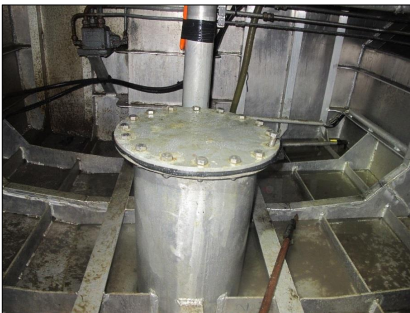
Figur 13: Inspeksjonsluken over propell/aksling akter i styrbord skrog. Foto: SHT
