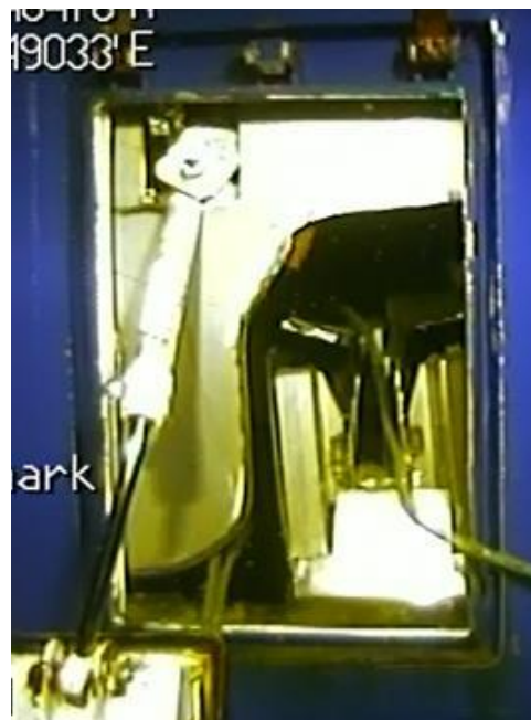
Figur 11: Påmontert ståplate på innsiden av skottet til setteluka for å redusere åpningen for vanninntrenging. ROV-foto: Safepath
