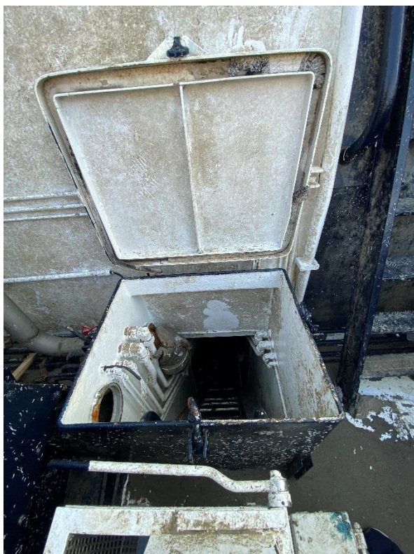
Figur 9: Nedgang til hydraulikkrommet og åpningen i siden av karmen. Foto: Sjøfartsdirektoratet
