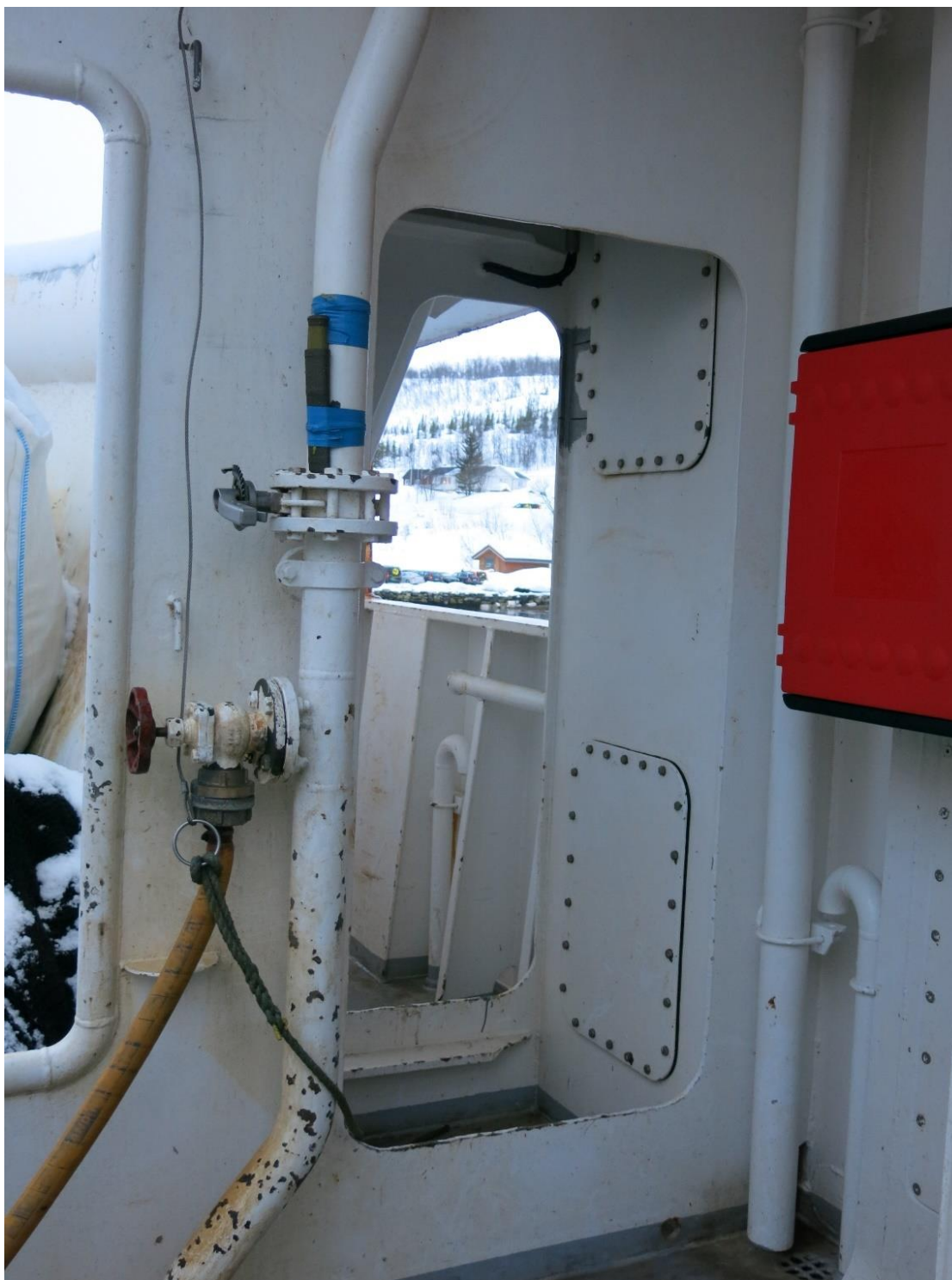
Figur 6: Dei to fiskarane gjekk ut på styrbord hjørne via utgangen på biletet. Foto: SHK
