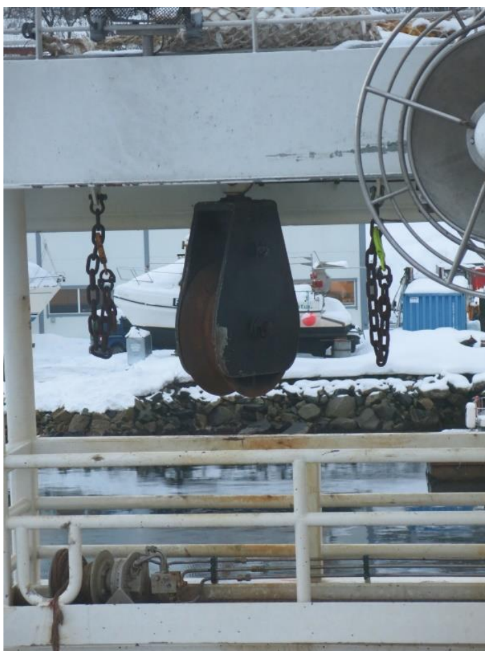
Figur 4: Styrbord blokk i styrbord galge der trålwiren til styrbord tråldør gjekk gjennom, og dei to sikringskjettingane for tråldøra. Styrmannen festa sikringskjettingane på tråldøra. Ei tilsvarande innretning var rigga for babord tråldør. Foto: SHK
