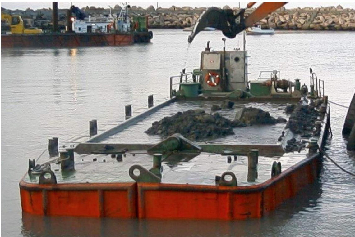
Figur 2: Splittlekter Mudder 073. Enheten var en ubemannet splittlekter som ble slept. Lekteren transporterte muddermasse til dumpeplass etter å ha blitt fylt opp av mudderapparatet som lekteren jobbet sammen med. Foto: Entreprenøren
