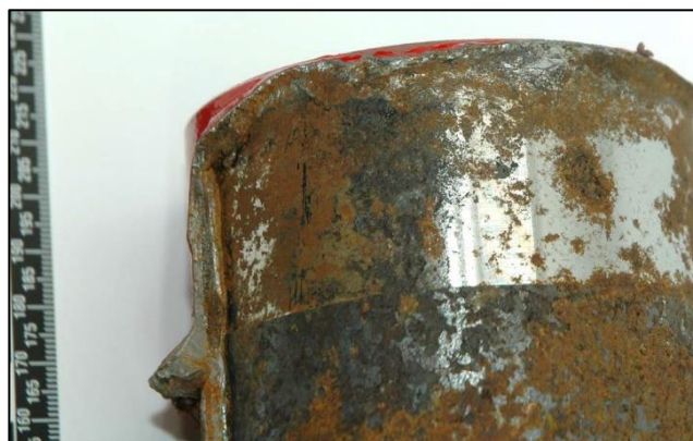
Figur 10: Brudd i sveis langs nakkebolt som viser dårlig innsmelting og reduksjon i det lastbærende tverrsnittet. Foto: FOLAT
