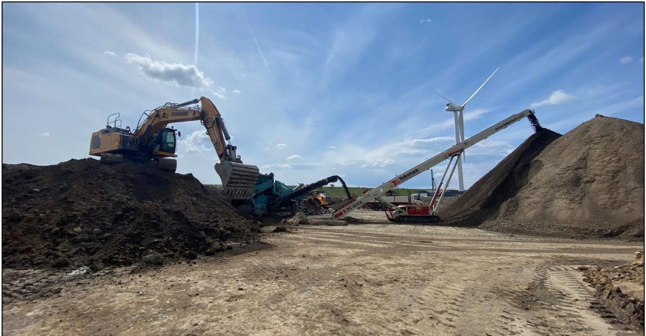
Figur 15: Norreccos jorrdeponi i Nordhavnen hvor lasten kom fra. Til venste er ubehandlet jord som blir blandet ved hjelp av en gravemaskin og transportet til en egen jordhaug plassert til høyre i bildet. Foto: SHK
