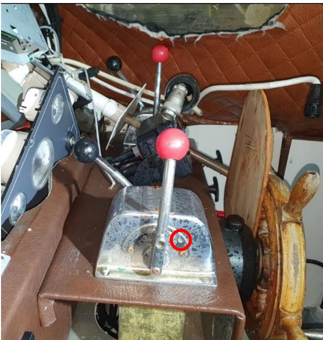
Figur 10: Sorte hendeler i posisjon som viser at motorene var koblet inn. Røde hendler har posisjon som viser pådrag fremover, og rød ring illustrerer nøytral posisjon for turtallet. Foto: Politiet
