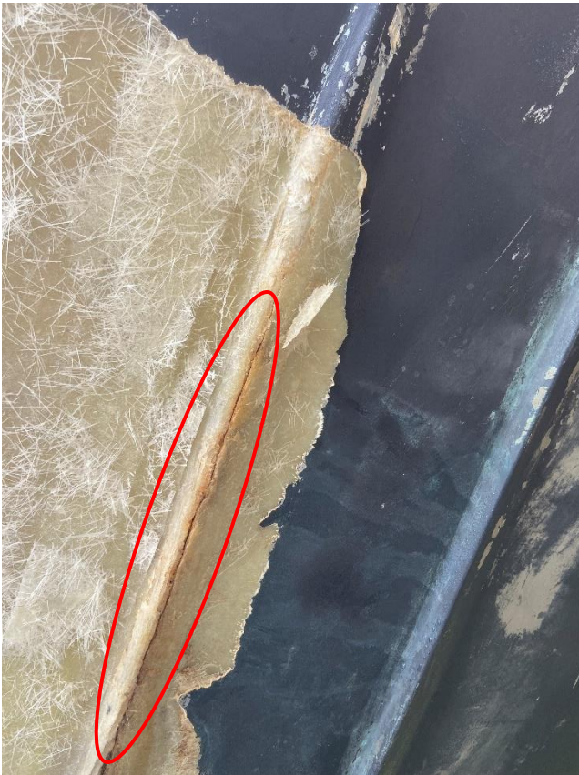
Figur 15: Reparasjonslaminat har løsnet fra skroget og de blanke overflatene viser at det har vært ingen eller dårlig vedheft i skadeområdet. Se deler av den gamle sprekken markert med rød ring. Foto: Konsulenten
