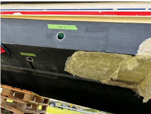
Figur 22: Kjerneprøve 2 og 3 på styrbord side. Foto: SHK
