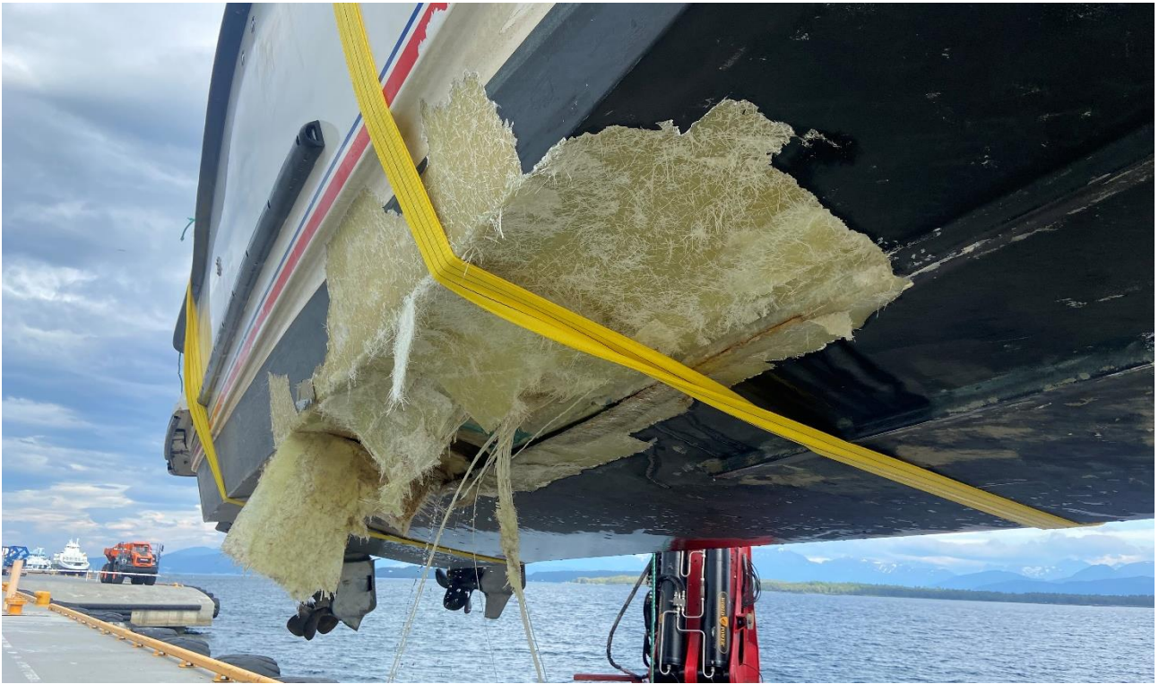
Figur 6: Oversikt over skadeområdet sett fra baugen. Foto: SHK
