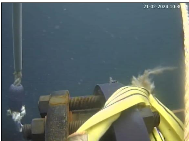
Figur 20: Lastestroppen sertifisert for løft på maksimalt tre tonn med slitasjeskade. Tauet til venstre i bildet er fortløyningsstauet, og har først blitt koblet til i etterkant av ulykken. Foto: Skarholm Dykking og Ingeniørtjenester AS
