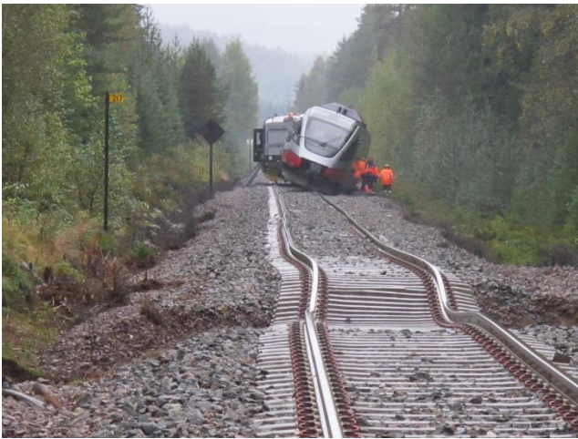
Figur 21: Persontoget der det stanset etter å ha kjørt over spor med utvasket underbygning ved Opphus i 2011. Foto: SHK
