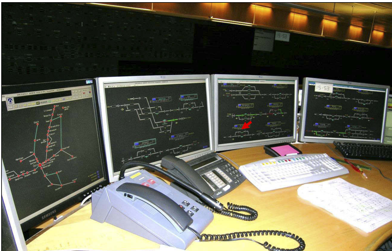
Figur 11: Togleders betjeningsplass for Gjøvikbanen. Rød pil viser Stryken stasjon. Storskjerm sees i bakgrunnen.
