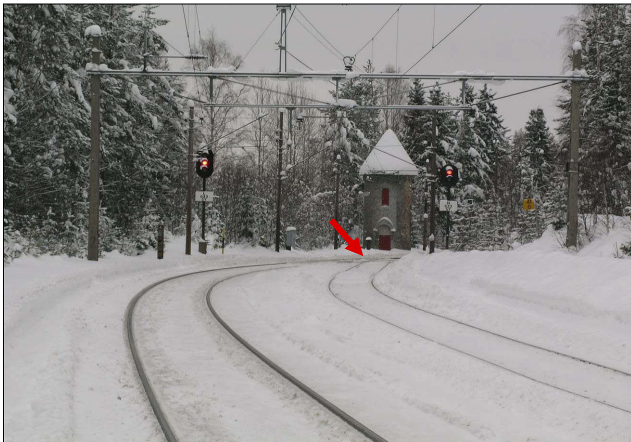
Figur 4: Bilde mot sporveksel 2. Sporet til venstre er gjennomkjørsporet, og sporet til høyre viser stedet som godstog 5512 kjørte inn og stoppet. Den siste vognen stoppet i området ved den røde pilen.
