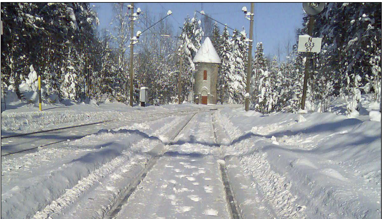
Figur 2: Bilde som viser snøforholdene inn i spor 02, fotografert samme dag etter at den alvorlige hendelsen inntraff. (Kilde: Olav Haugen, Jernbaneverket)
