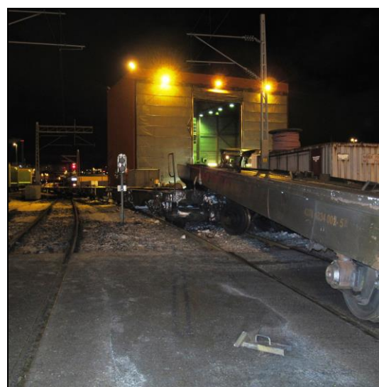
Figur 6: Viser deler av vognstammen som skulle skiftes til spor C31. I bakgrunnen garasje for containertrucker. Foto: SHT
