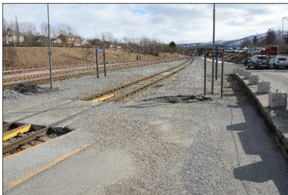
Figur 2: Skilting mot spor 2, taktil merking synlig under grus. Foto: SHT
