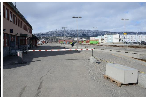
Figur 3: Bom inn mot publikumsområdet, betongblokker med kjetting leder gangtrafikk inn rett vei på overgang. Foto: SHT
