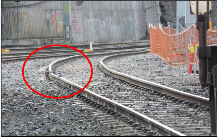
Figur 19: Svank i spor ved avspingssted etter avsporing. Foto: SHT
