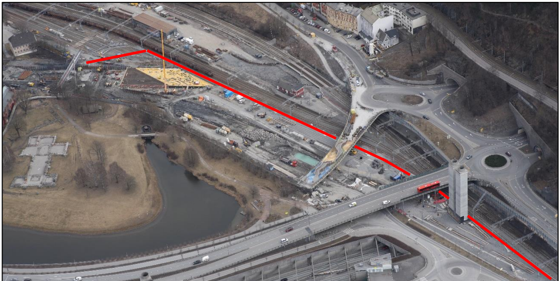
Figur 14: Flyfoto over Loenga stasjon og anleggsområde for prosjektet. Foto: Bane NOR SF, grense markert av SHT
