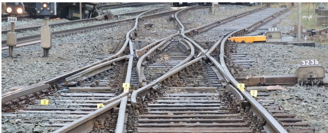
Figur 12: Situasjonsbilde av skader i sporvekselen og i sporet. Foto: SHT
