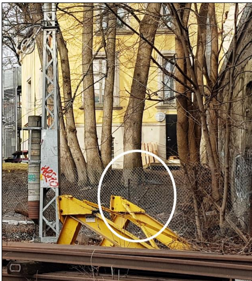
Figur 7: Sirkel viser området ved Munkedamsbroen hvor det var hull i gjerdet. Gjerdet er her tettet etter at nødetatene benyttet stedet som passasje. Foto: Bane NOR SF
