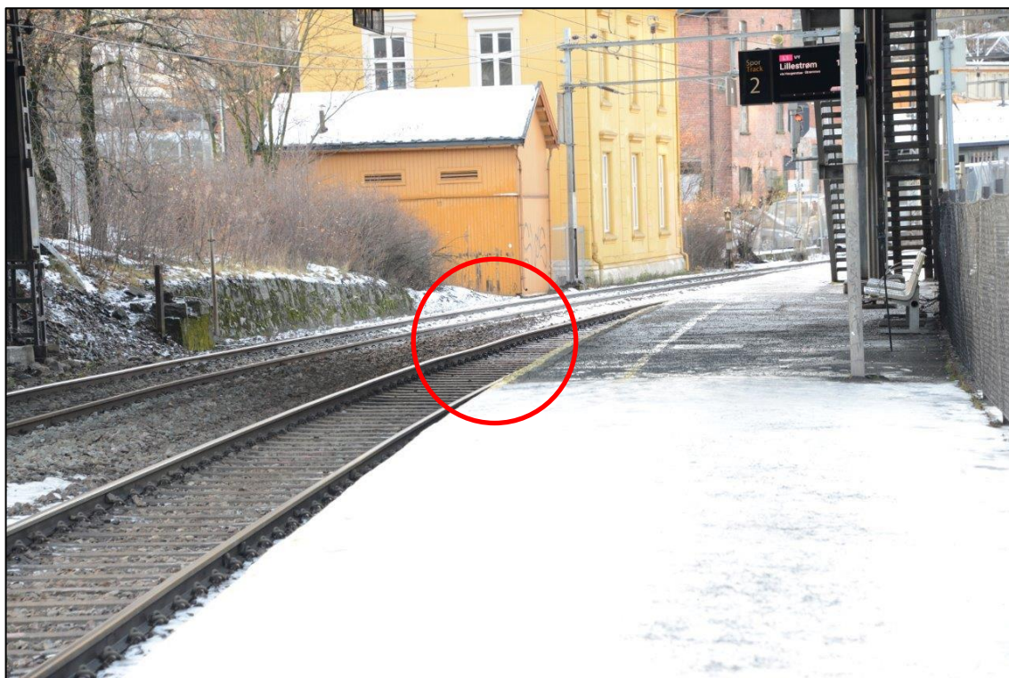
Figur 9: Setning i sporet ved km 3,98 Bryn stasjon. Foto: SHT
