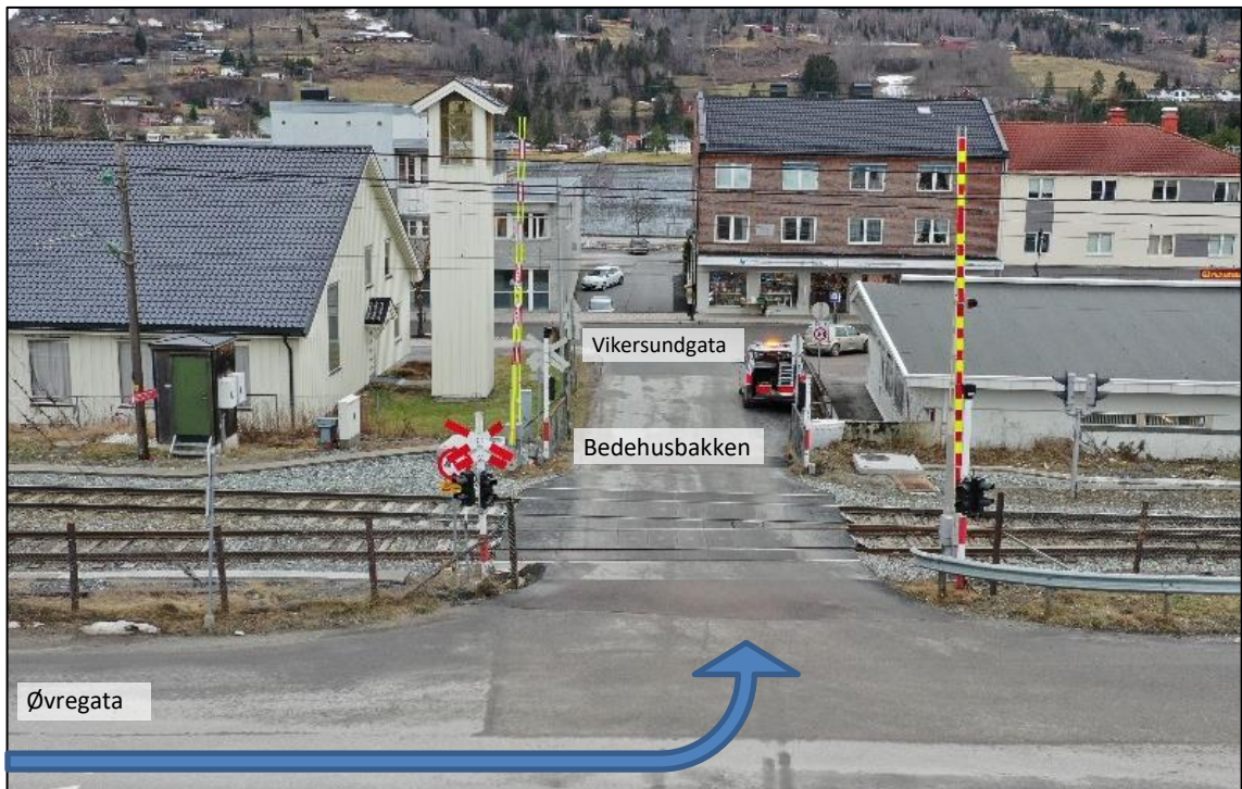
Figur 2: Vikersund planovergang 1 med bilens kjøretning. Toget kom fra venstre. Foto: Statens vegvesen
