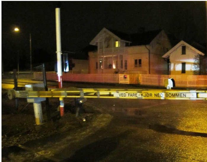
Figur 6: Tekst på bomarm på Vikersund planovergang 1. Foto: SHK
