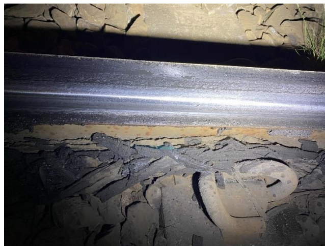
Figur 22: Slitt skinnehode i innerkurve – dette medfører økning av sporvidden. Foto: SHK
