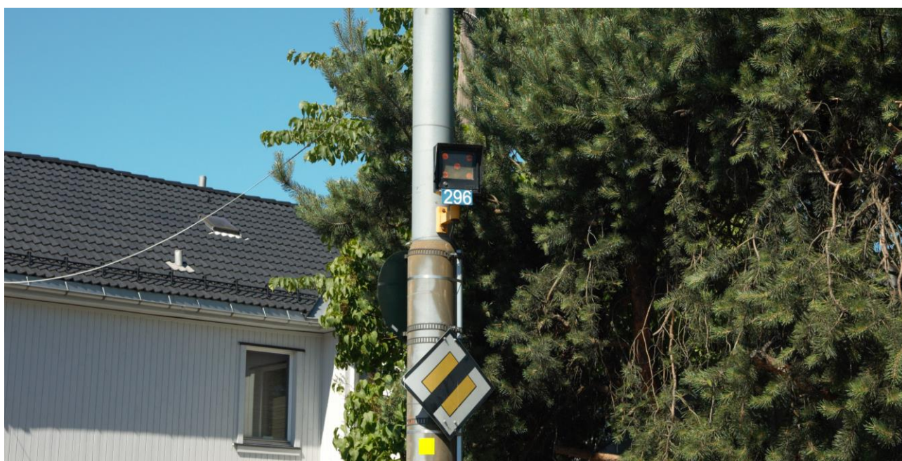
Figur 5: Sporvekselsignal med kube. Signaltube viser at sporveksel er låst i stilling og ligger i kontroll. Foto: SHK
