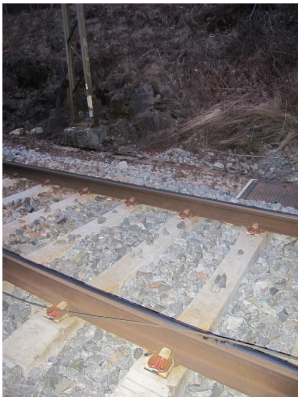
Figur 15: Bærelina har sveiset seg fast mot skinnen. Foto: SHK
