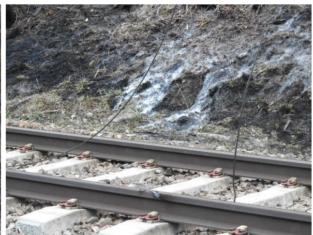
Figur 12: Hengende bæreline. Foto: SHK
