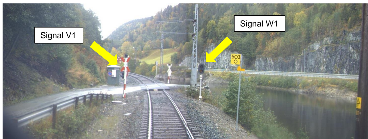
Figur 19: Hagamælen planovergang sett fra Bane NORs målevogn. Foto: Bane NOR SF med markeringer av SHK
