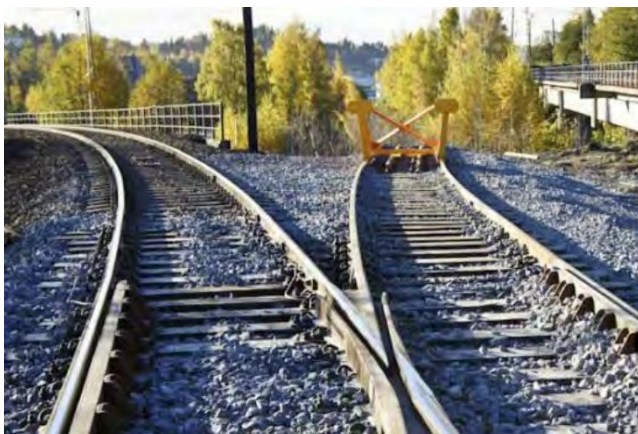
Figur 14: Avledende sporveksel 30 på Alnabruterminalen med glidbar sporstopper. Foto: Bane NOR
