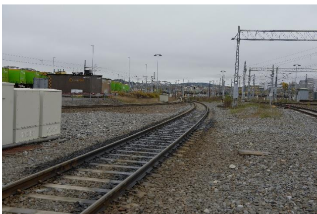
Figur 2: Stedet der lokomotivet startet, retning sør. Foto: SHK
