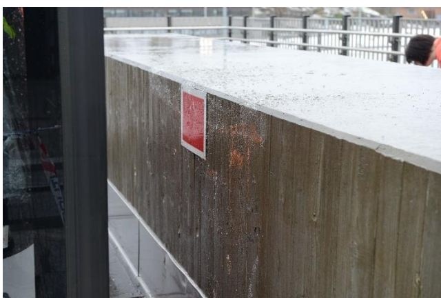
Figur 4: Lakk- og glassrester fra vogn 228 avsatt i øvre del av endebutten. Foto: SHK
