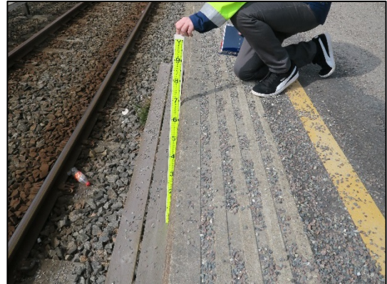
Figur 19: Nedfallssikring på Holstein T-banestasjon. Foto: SHT
