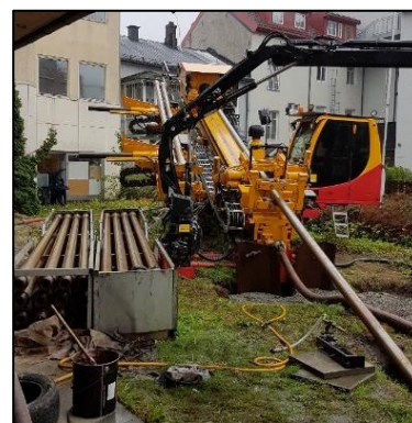
Figur 7: Borerigg. Foto: Bane NOR SF
