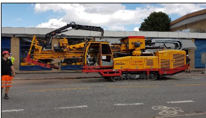
Figur 6: Borerigg. Foto: Bane NOR SF
