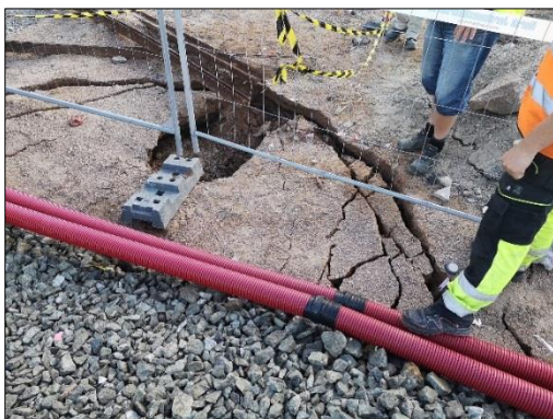
Figur 4 Synkehull innenfor byggegjerde. Foto: Bane NOR SF
