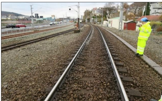
Figur 7: Første merke i skinnegangen, ca. 200 m fra bakre vogn. Foto: SHK
