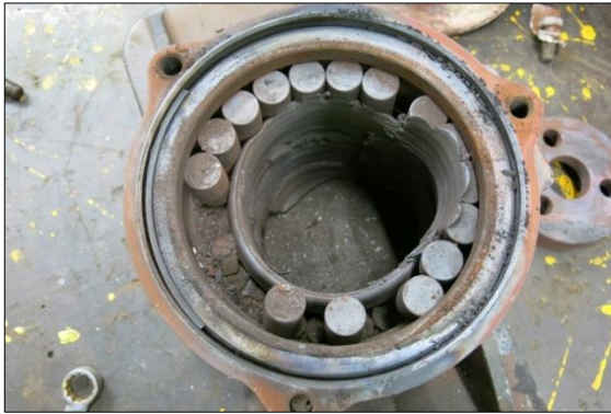
Figur 51: Ruller i ytre lager. Foto: SHK
