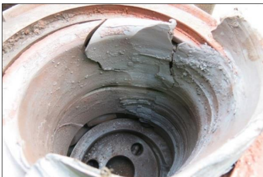
Figur 23: Innvendig i lager. Foto: SHK
