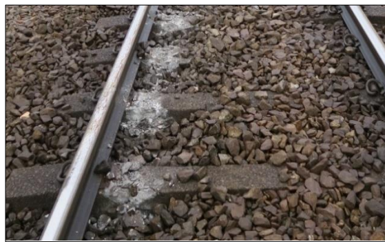
Figur 8: Store merker på venstre skinne hvor avsporingen startet. Foto: SHK
