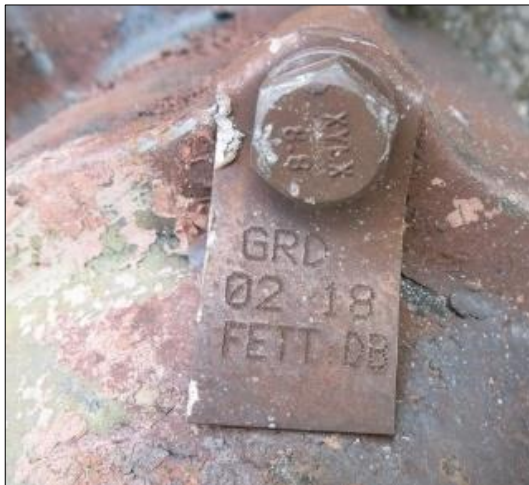
Figur 19: Skilt med verkstedkode, dato og fettype. Foto: SHK
