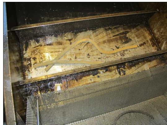
Figur 84: Gjenbruk av filttetting. Foto: SHK
