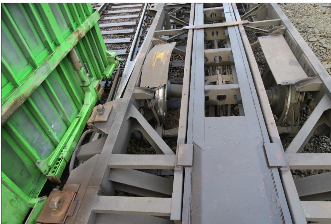
Figur 6: Hjul med lagerhavari på avsporet vogn. Foto: SHK
