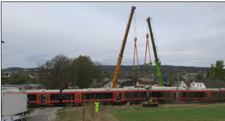
Figur 13: Berging av togsett. Foto: SHK
