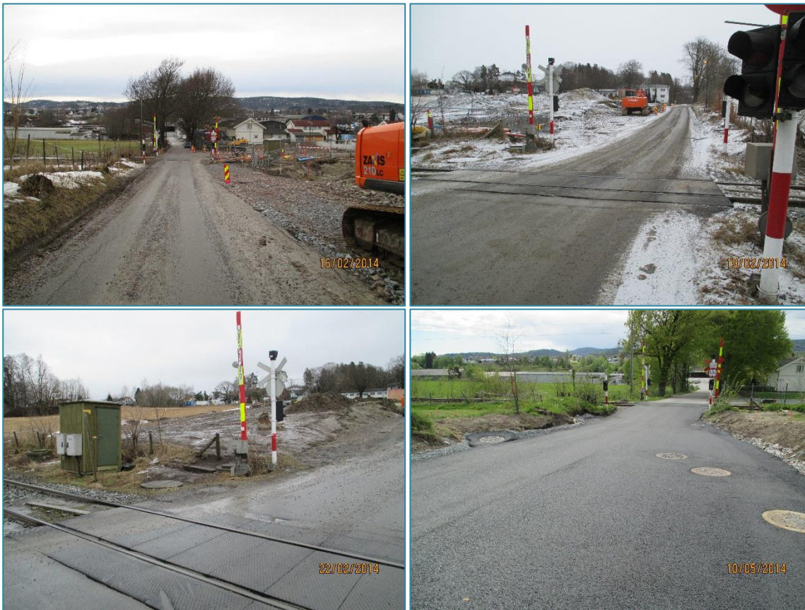
Figur 100: Foto fra arbeider nær planovergangen tatt februar–mai 2014. Foto: Skien kommune
