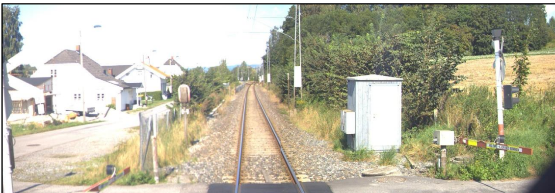
Figur 46: Sikt i togets kjøreretning. Foto: Bane NOR målevognsbilder, 2019
