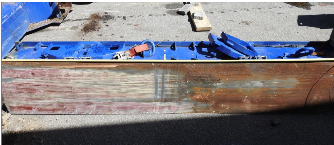
Figur 29: Skrapemerker under den bakre vangedelen på trallens høyre side. Foto: SHK
