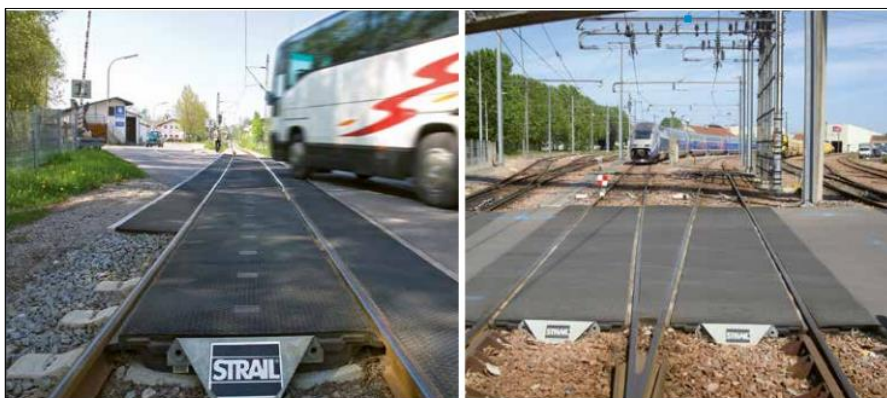
Figur 54: Ulike konfigurasjoner av Strailelementer med og uten T-blokk. Kilde: Strail DE 10
