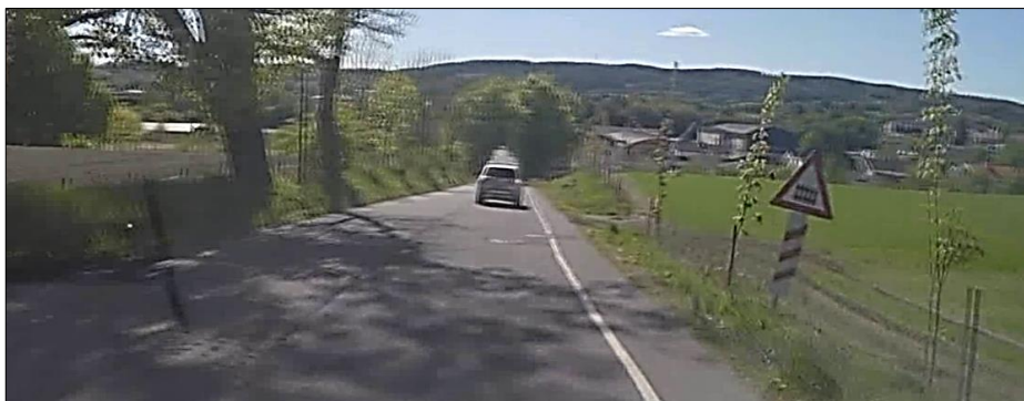
Figur 32: Borgestadbakken ned mot planovergangen (i samme retning som vogntoget kom kjørende). Foto: SHK
