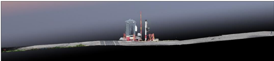
Figur 92: Behandlet 3D-bilde med lengdeprofil av veien. Dronefoto: SHK
