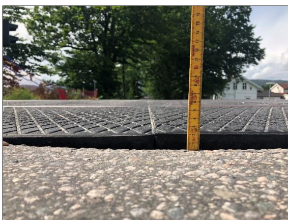
Figur 55: Høydeforskjell mellom asfalt Strailelement, 29. juni 2020. Foto: SHK
