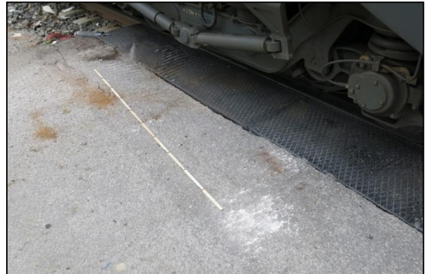
Figur 41: Skrapemerker i asfalten på vestsiden av planovergangen. Foto: SHK
