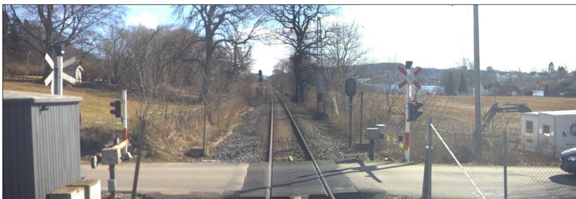
Figur 45: Sikt i retning mot toget. Kilde: Bane NOR målevognsbilder, 2016
