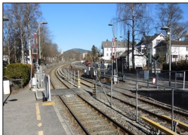
Figur 2: Oversiktsbilde Steinerud planovergang. Foto: SHT
