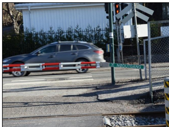
Figur 5: Helbom sett fra innsiden. Foto: SHT
