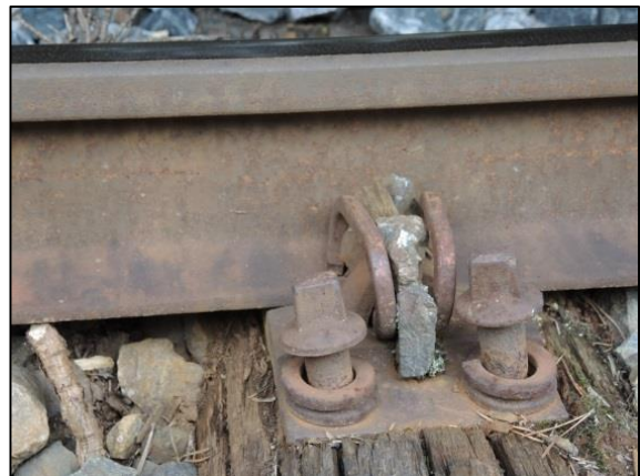
Figur 15: Løse svilleskruer. Foto: SHT
