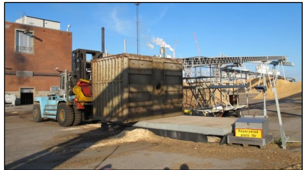
Figur 28: Fliscontainerne veies før de tømmes. Foto: SHT
