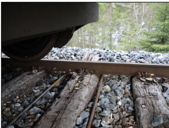
Figur 16: Strekkbolter. Foto: SHT
