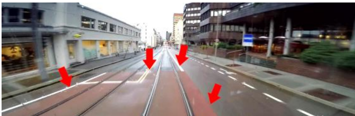
Figur 9: Viser eksempler på markering av asfalten som hvit/gul stripe, kantstein og rød maling. Foto: Keolis Norge AS
