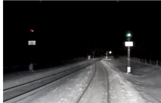
Figur 15: Utkjørhovedsignal L og N. Foto: SHT
