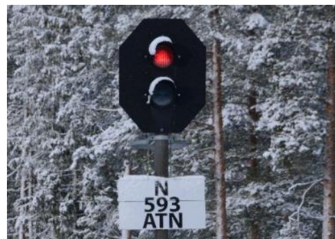
Figur 6: Detaljbilde av signal N. Foto: SHT
