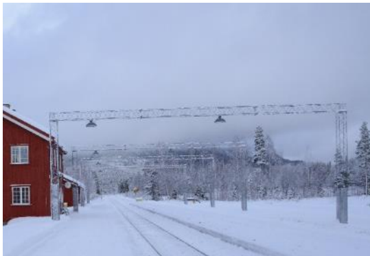
Figur 3: Atna stasjon retning Hanestad (Nord). Foto: SHT
