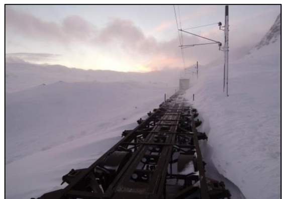
Figur 18: Togstammen ble pakket inn med snø i løpet av noen timer etter avsporingen. Foto: Jernbaneverket
