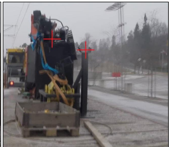
Figur 16: Bevegelse ved ujevnheter. Foto: SHT
