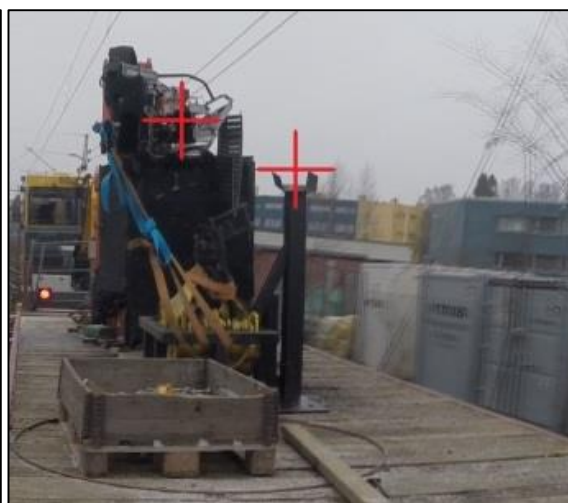
Figur 19: Stoppes i sikringen. Foto: SHT
