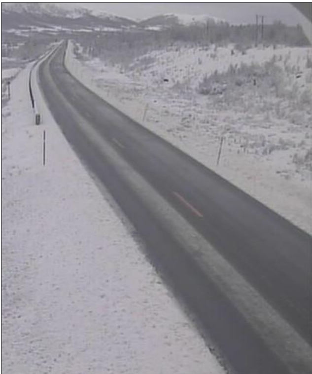
Figur 12: Det var nesten bar veg ved Avsjøen vårstasjon (ca. 14,8 km sør for Grønbakken vårstasjon og ca. 16,3 km sør for ulukkesstaden) om lag åtte minutt før ulukka skjedde. Foto: Statens vegvesen (Vegvær)
