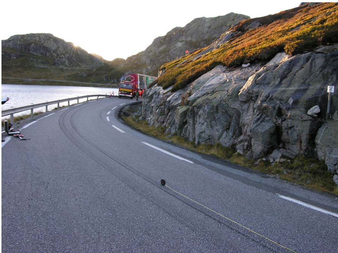
Figur 2: Skrensespor i skarp høyrekurve
