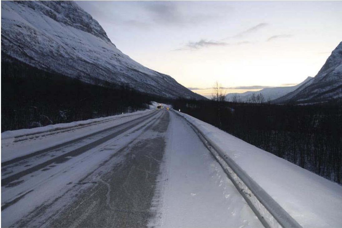
Figur 13: Viser veistrekningen hvor ulykken inntraff. Bildet er tatt i personbil (A) sin kjøreretning dagen etter ulykken og viser at nedfrest profilert varsellinje er delvis dekket av is og snø. (Foto: Politiet)
