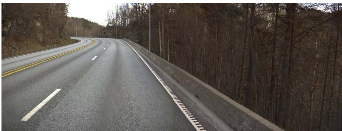
Figur 9: Bildet viser veimerkingen og inngangen til ulykkessvingen sett i personbilens kjøreretning. (Kilde: Statens vegvesen).
