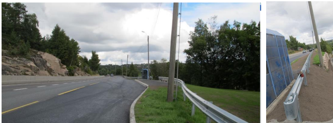
Figur 15: Bussholdeplassen Rommi etter ombyggingen våren/sommeren 2014 og nærbilde av stålrekkverket som erstatter betongrekkverket. Foto: SHT
