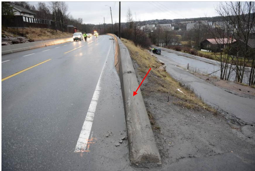
Figur 12: Skrapemerker etter bussen på betongrekkverket. Bildet er tatt fem dager etter ulykken i bussens kjøreretning. Foto: SHT
