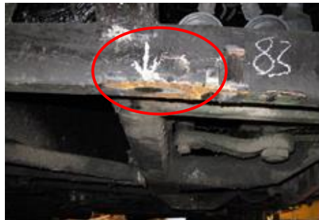
Figur 11: Nærbilde som viser treffpunktet med betongrekkverket. Foto: SHT
