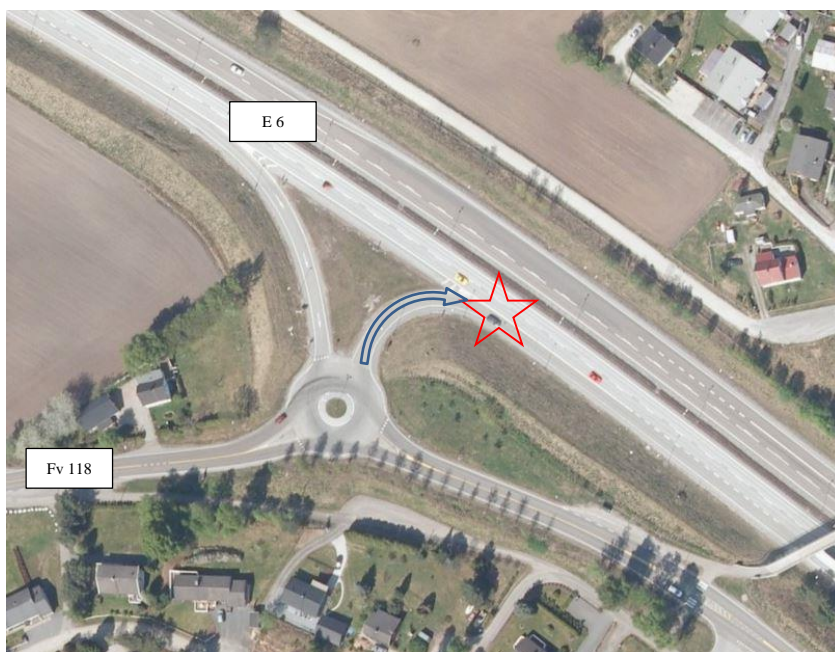
Figur 12: Oversiktsbilde E 6 ved Missingmyr, Råde. Kart: Statens vegvesen
